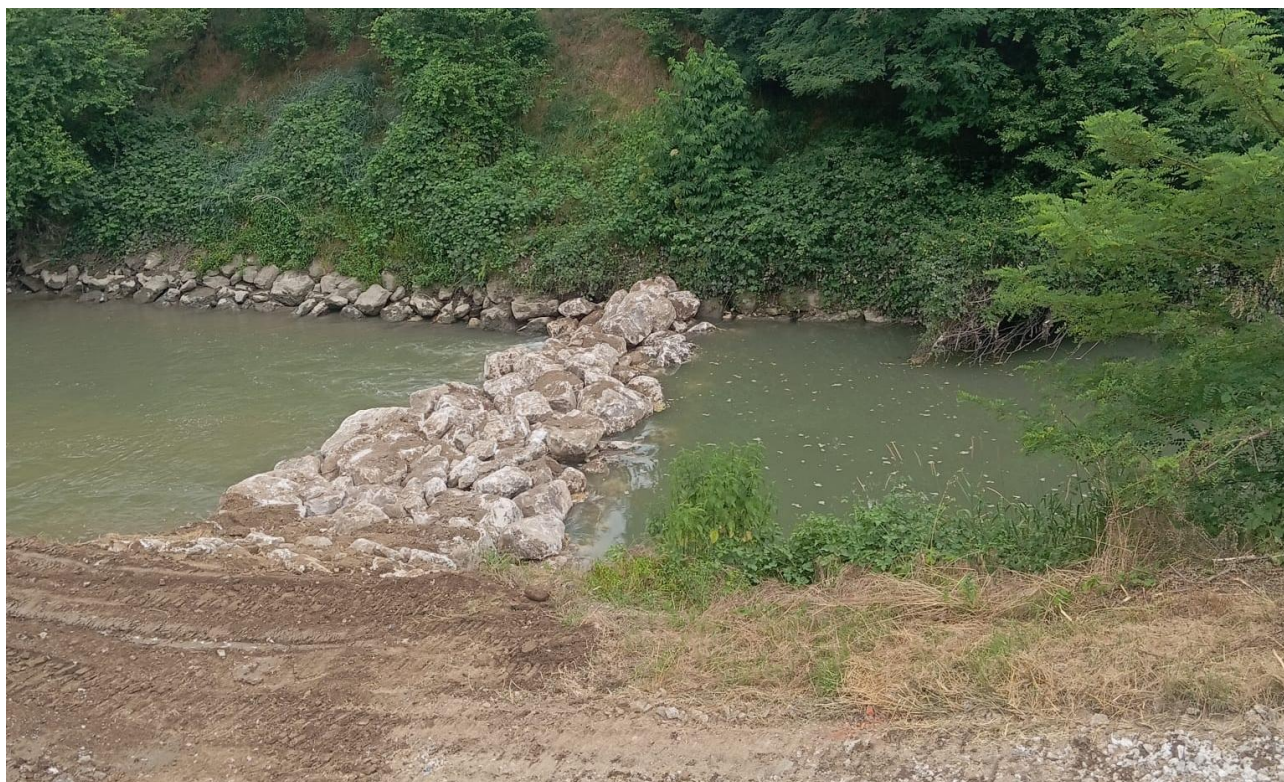
Figura 8 - La traversa provvisoria che si realizza per l'impianto Bondiocca.
