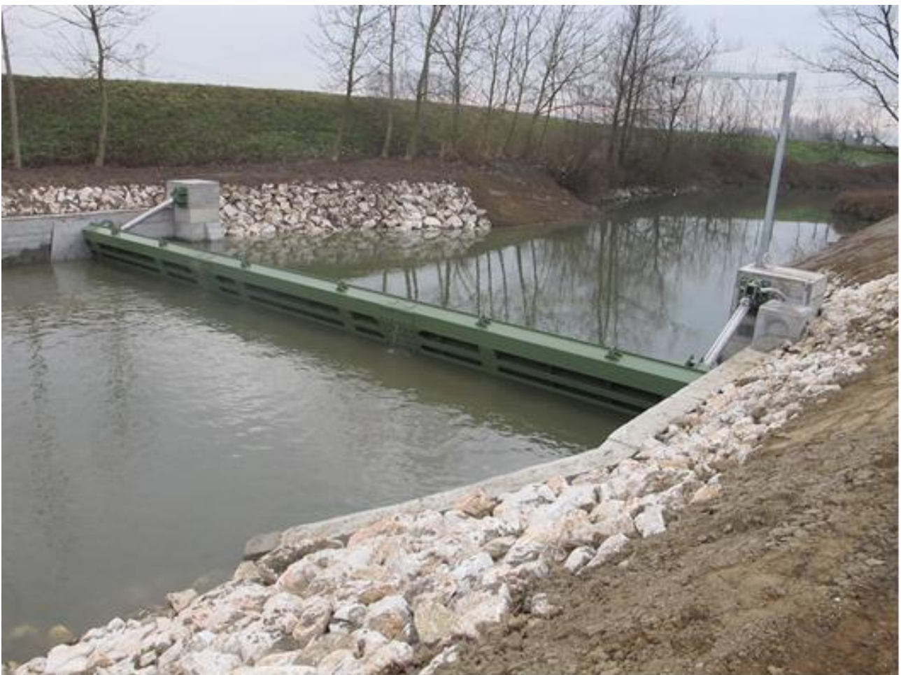
Figura 10 - Una delle traverse già realizzate sul Collettore Generale di Bonifica. Per l'impianto Bondiocca, si è prevista la realizzazione della medesima tipologia.
