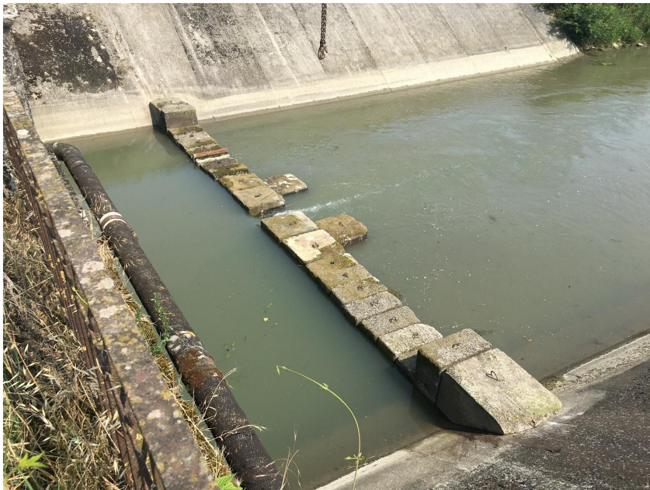
Figura 7 - La traversa provvisoria che si realizza per l'impianto Mezzano Vecchio.
