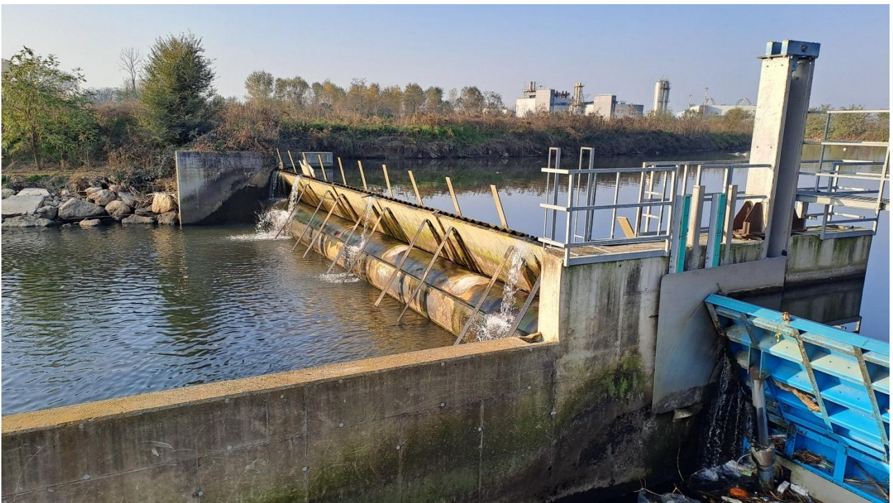
Figura 11 - Esempio di traversa mobile azionata mediante tubolare gonfiabile, analoga per funzionamento a quella scelta per l'impianto Mezzano Vecchio.
