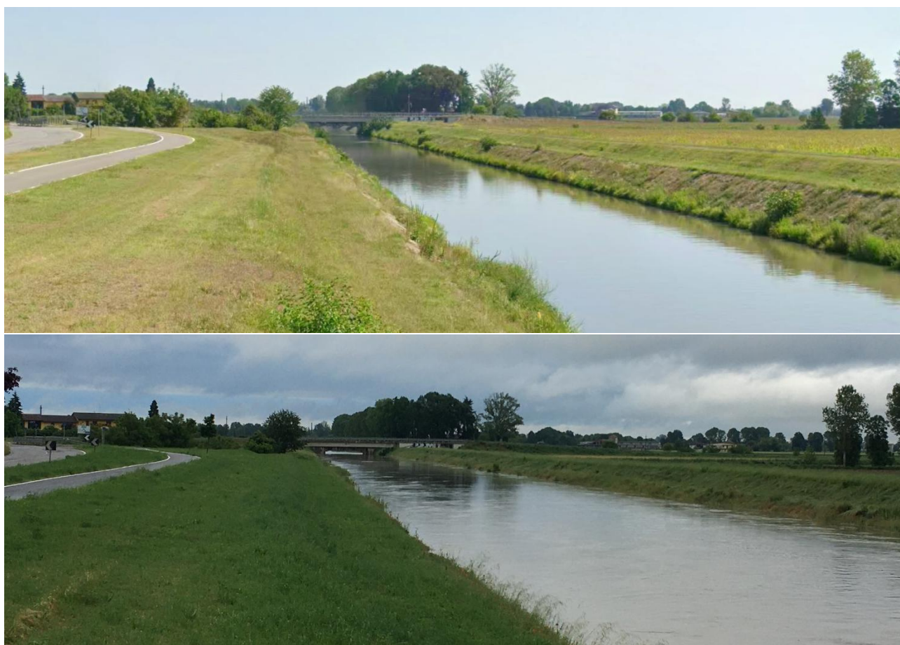
Figura 4 - Tratto Allacciante del Collettore Generale di Bonifica in prossimità di S. Stefano Lodigiano, poco a monte dell'impianto Mezzano Vecchio. In alto, durante l'esercizio irriguo con buona disponibilità idrica, in basso in condizioni di piena interna (maggio 2024).
